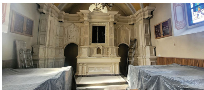
W kościele trwają prace przy konserwacji drewnianego wyposażenia kościoła.
