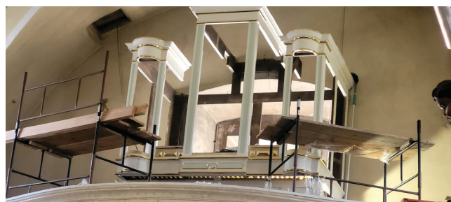
Szafa organowa została pomalowana i wyłożona. Trwa montaż organów.
