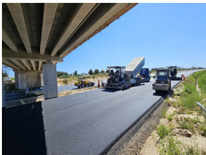
Obwodnica Opatowa, widok w kierunku południowym, obiekt WD-4
