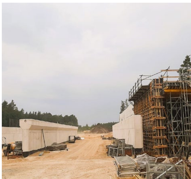
Obwodnica Wąchocka - roboty konstrukcyjne, deskowanie
