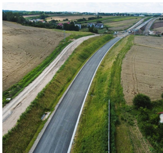
Ponad 90 procent odcinka obwodnicy Ostrowca ma już warstwę wiążącą nawierzchni.
