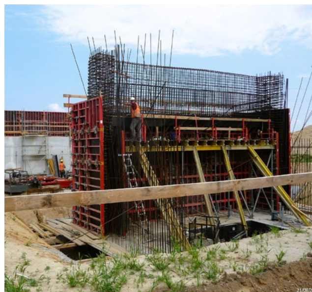
Obwodnica Opatowa - budowa łącznika północnego
