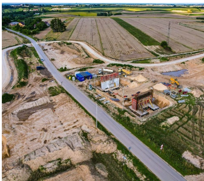
Obwodnica Opatowa - łącznik północny, 23-km 1 680 WD-2B ul. Lipowska
