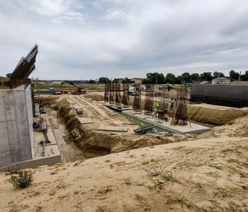
Zdjęcia 1 i 2. Budowa obwodnicy Opatowa
