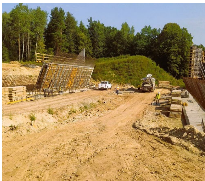
Obwodnica Wąchocka - przejście ekologiczne, roboty-zbrojarskie km14200
