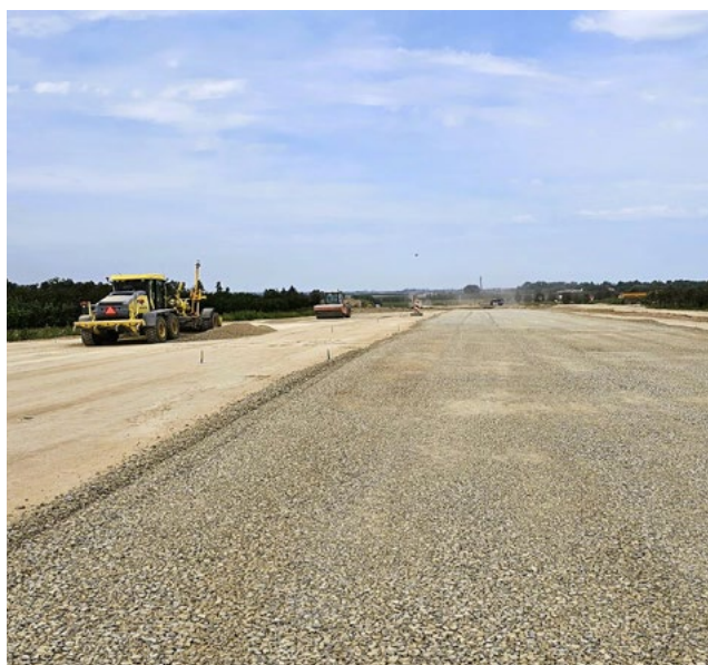
Budowa-obwodnicy Opatowa-w ciągu-S74-i-DK9_S74-km-8900. Widok w kierunku północnym
