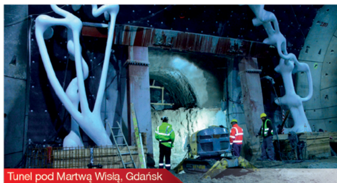
Tunel pod Martwą Wisłą, Gdańsk
