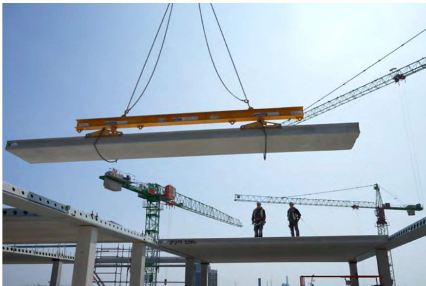
Rys. 3 Podnoszenie płyty HC
