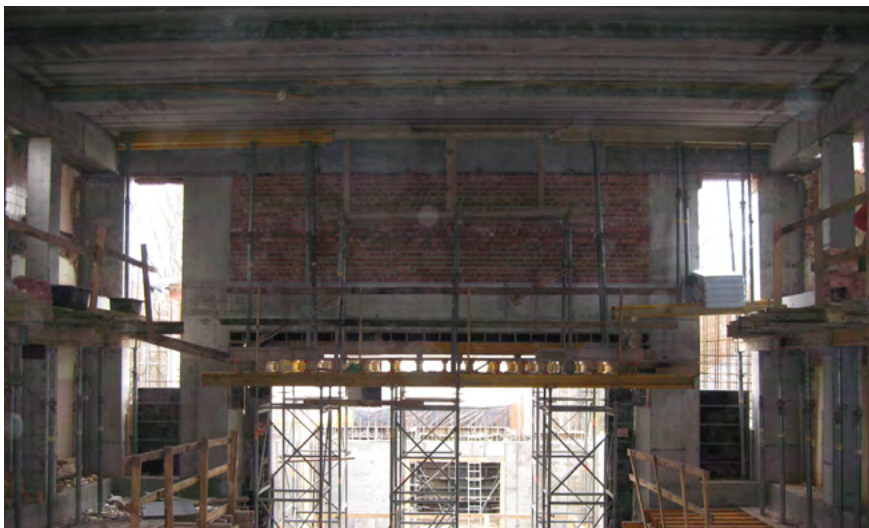
Rys 5 Widownia teatru zamknięta od góry płytami HC. Budowa Teatru Lalki i Aktora Kubaś na Wzgórzu Zamkowym w Kielcach
