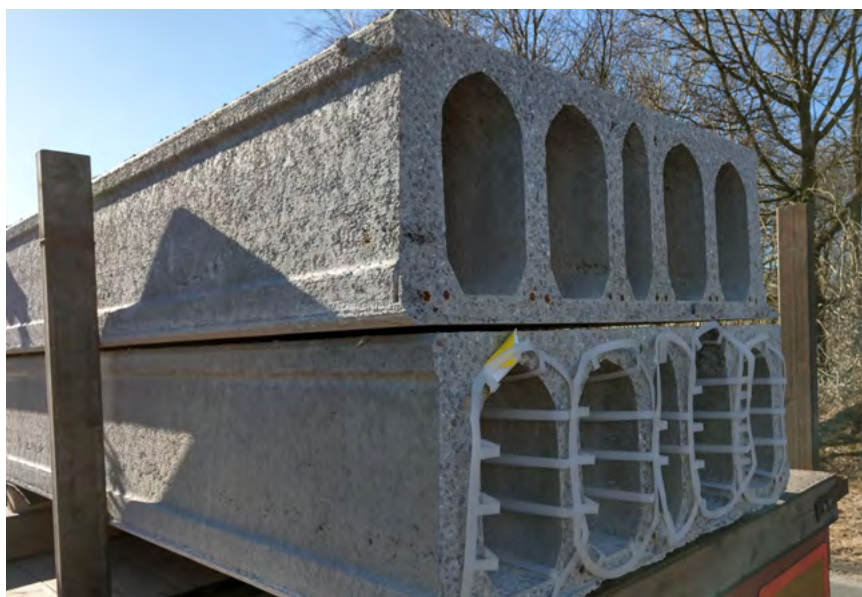
Rys. 2 Widok przekroju poprzecznego płyty HC
