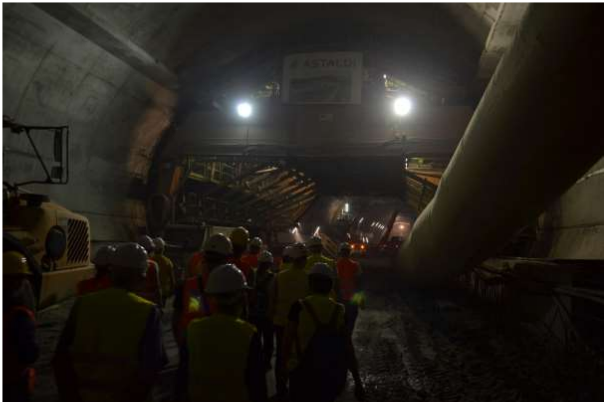
Fot. 2. Żelbetowa obudowa komory tunelu
