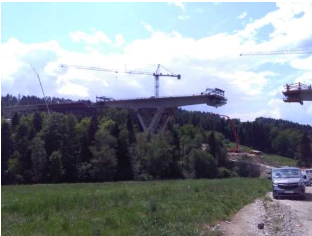
Fot. 7. Budowa estakady o roboczym oznaczeniu 21 – widok z boku na przęsło wykonywane metodą nawisową
