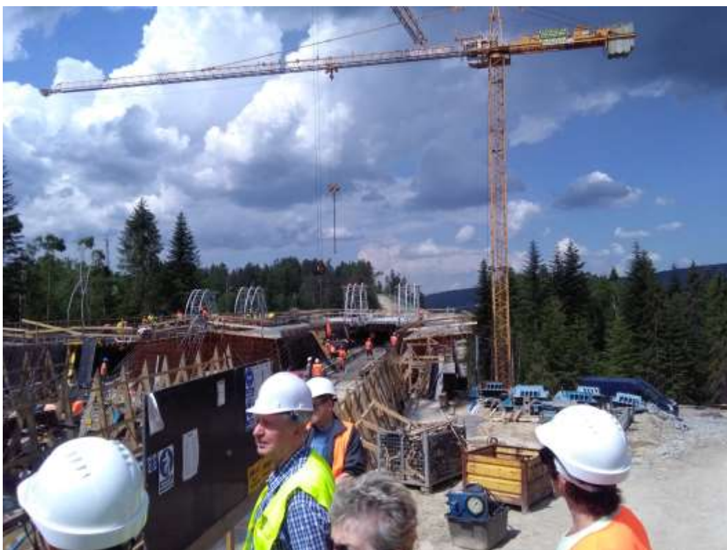
Fot. 8. Budowa estakady o roboczym oznaczeniu 22 – widok na stanowisko do nasuwania podłużnego
