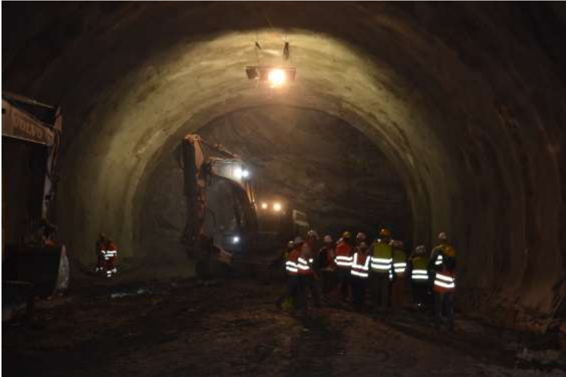
Fot. 3. Prace drażeniowe na przodzie komory tunelu
