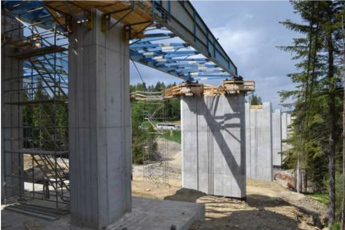
Fot. 9. Budowa estakady o roboczym oznaczeniu 22 – widok na awanbąg
